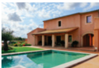
Prvotřídní renovovaná pasivní vila „Proyecto Tierra“ ve městě Lucmajor, Mallorca (Španělsko)
