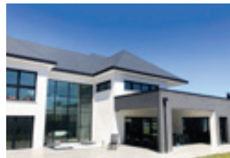
Dům s plochou 610 m 2 s podlahovým topením a TUV v obci Saint-Prest (Francie)
